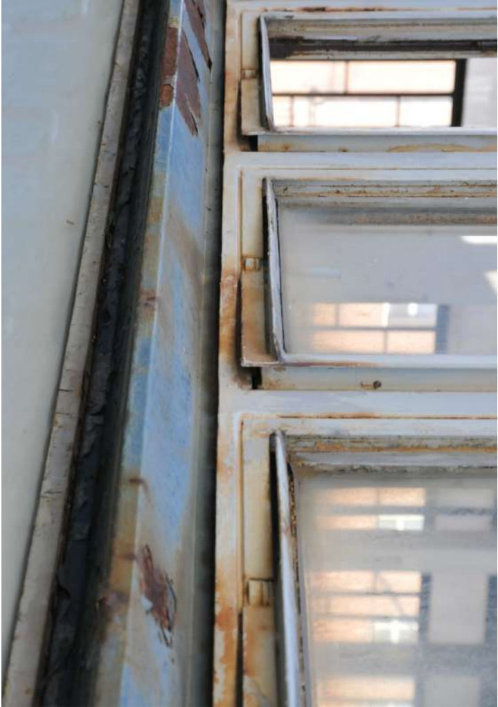
Fotografia di dettaglio sull'apertura a bilico delle finestre perimetrali.
