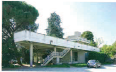
Das Gebäude der Sozialdienste bietet mit seinem überdachten Vorbereich und den Terrassen Platz für Aktivitäten im Freien.
